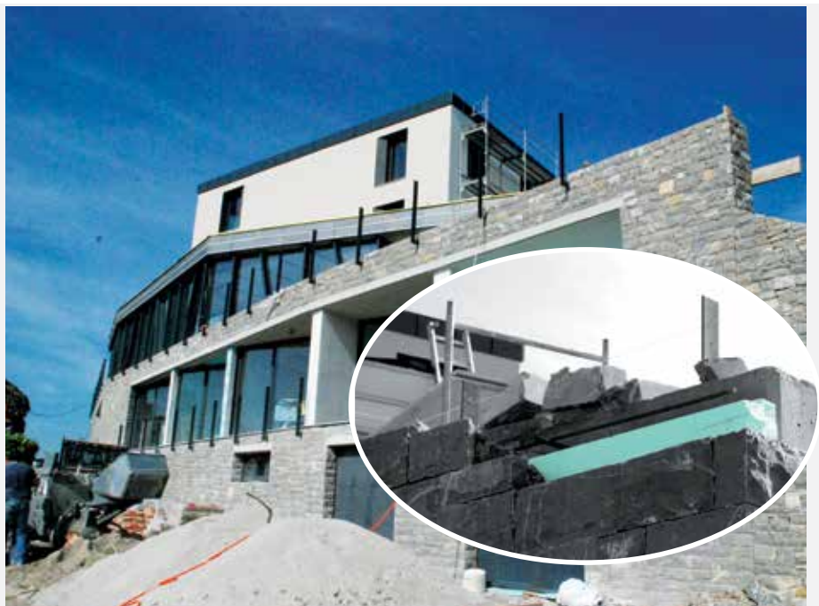
Facciata in pietra naturale di un albergo realizzata con pannelli portanti FIBRANxps ETICS BT sui quali è stato applicato il rivestimento pesante
