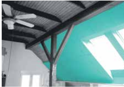
Realizzazione di isolamento termico dall'interno con pannelli FIBRANxps ETICS , che verranno intonacati o verniciati.
