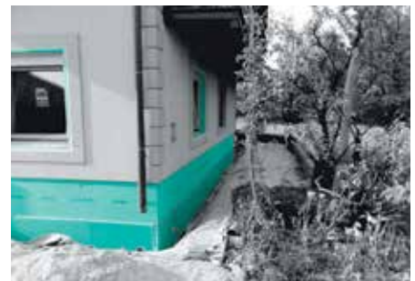
Isolamento termico dei ponti termici delle spallette e della zoccolatura con pannelli FIBRANxps ETICS
