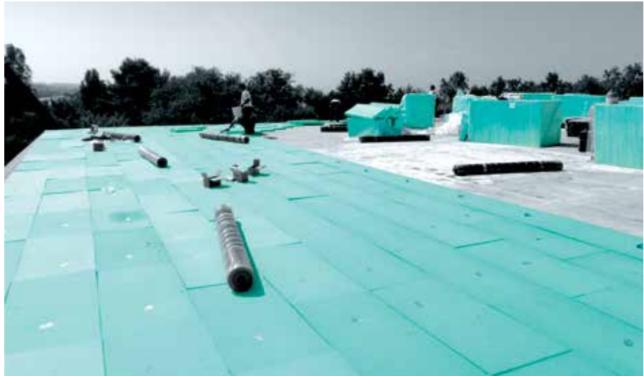
Aumento della pendenza e risanamento dell'isolamento termico di un tetto piano con pannelli FIBRANxps INCLINE
