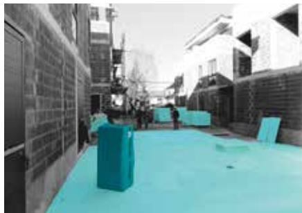
Realizzazione della pendenza e dell'isolamento termico di un solaio calpestabile di un condominio con due piani sotterranei
